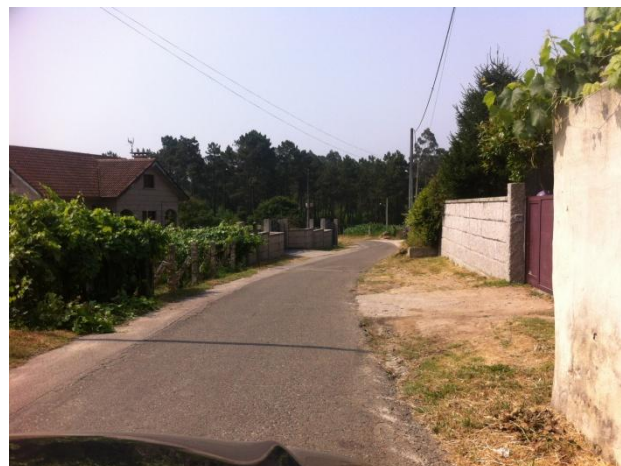
Estado actual en un tramo intermedio
