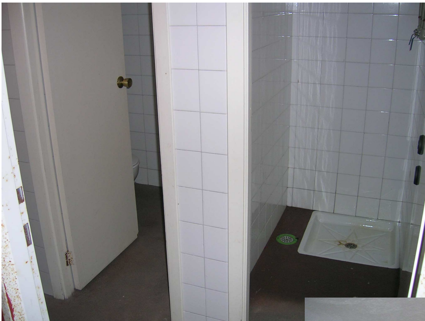
Foto 7 Vista dos vestiarios de árbitros.
