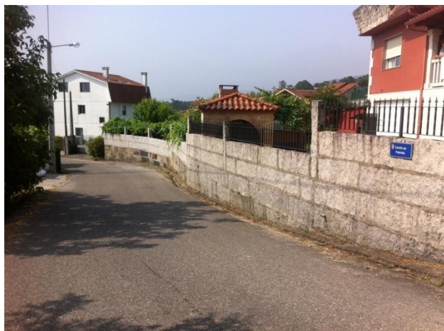
Estado actual del Tramo inicial
