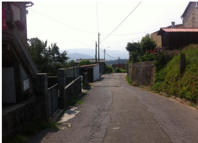
Estado actual del Tramo inicial
