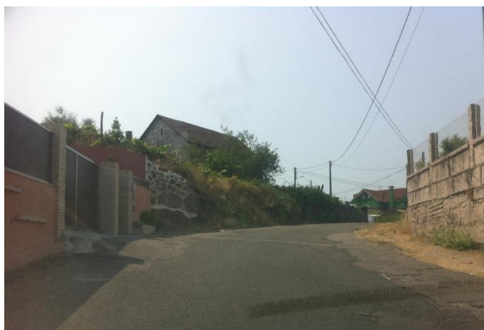
Estado actual del Tramo inicial
