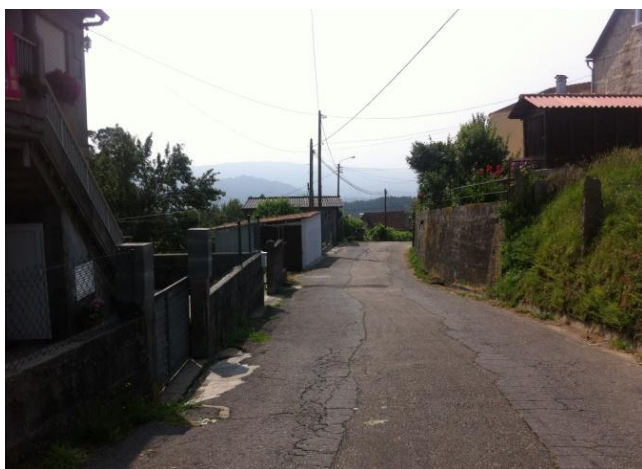
Estado actual del Tramo inicial
