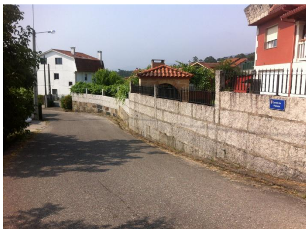
Estado actual del Tramo inicial
