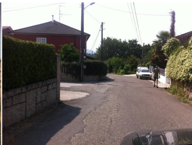
Estado actual en el PK 0+530
