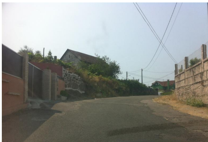
Estado actual del Tramo inicial
