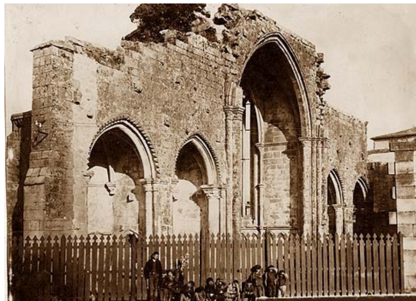
Figura 2: Vista de las Ruinas de Santo Domingo con la valla de madera exterior
