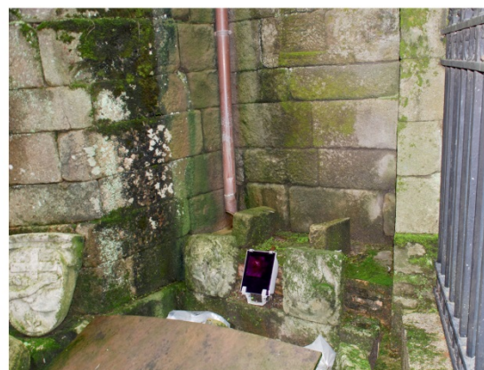
Figura 9: a pesar de la protección de las cubiertas y de la instalación de bajantes, está claro que se producen escorrentías y retenciones de humedad que favorecen la colonización. En los salientes de la fábrica no es posible o fácil controlar la retención de humedad, pero en las partes bajas de la edificación se puede mejorar mucho la situación. Además, en estas zonas se producen alteraciones importantes con pérdida de material.
