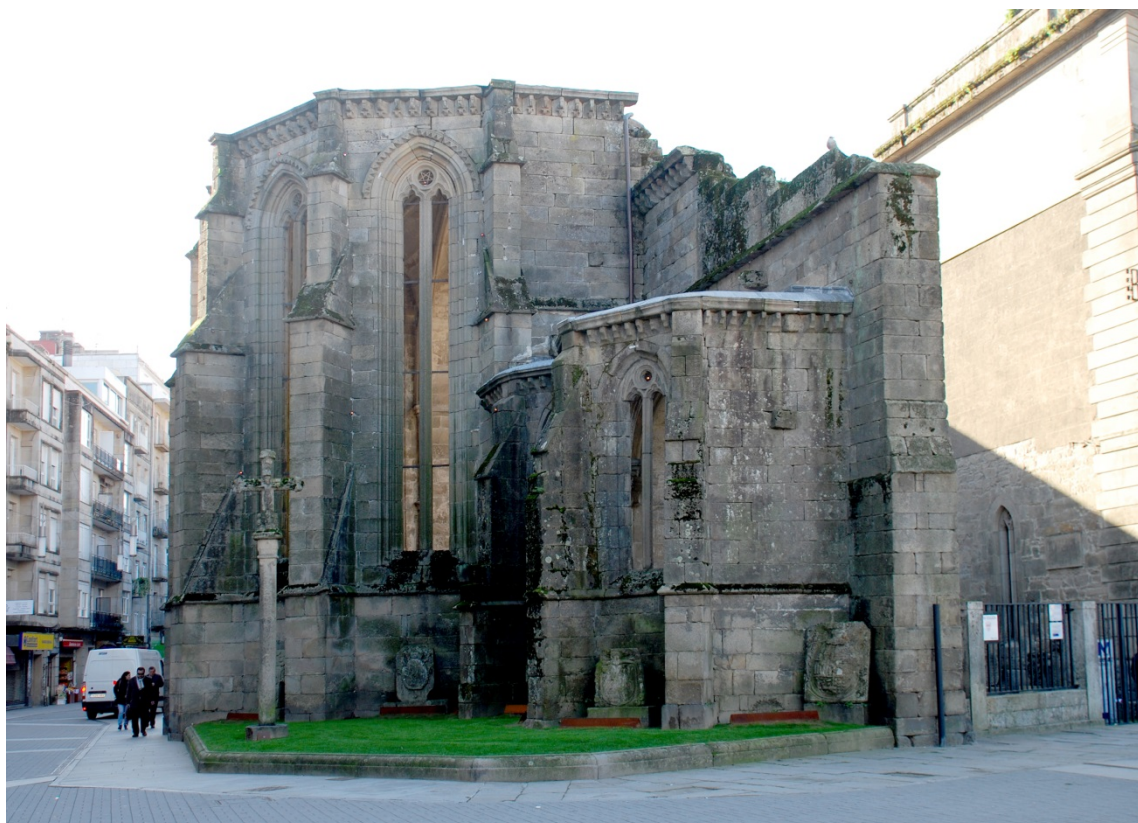
Figura 5: aspecto actual de la cabecera conservada. Comparada con la situación de los primeros años, tras el intento de demolición, la imagen ha cambiado en zonas concretas que ahora están reconstruidas: segundo absidiolo de la Epístola y hastial. Estas reconstrucciones son seguramente las realizadas por Menéndez Pidal y Pons Sorolla. En la actualidad, la colonización biológica más intensa de la fábrica exterior, se detecta en los muros orientados al norte.
