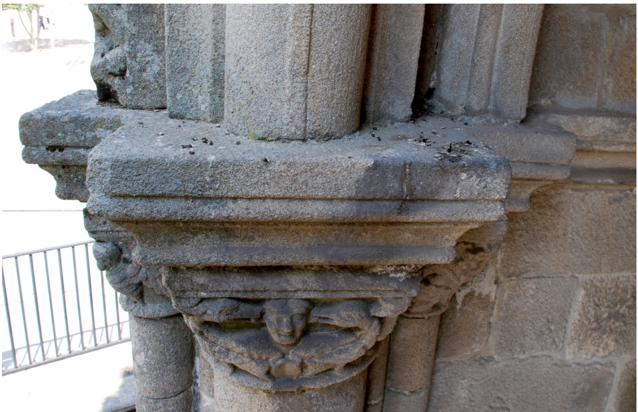
Figura 14: en todo la ruina se detectan manchas negras; una parte seguramente se deben a la colonización biológica, pero otras parece bastante claro que están constituidas por yeso de neoformación (costra negra). También hay algunas acumulaciones de guano.
