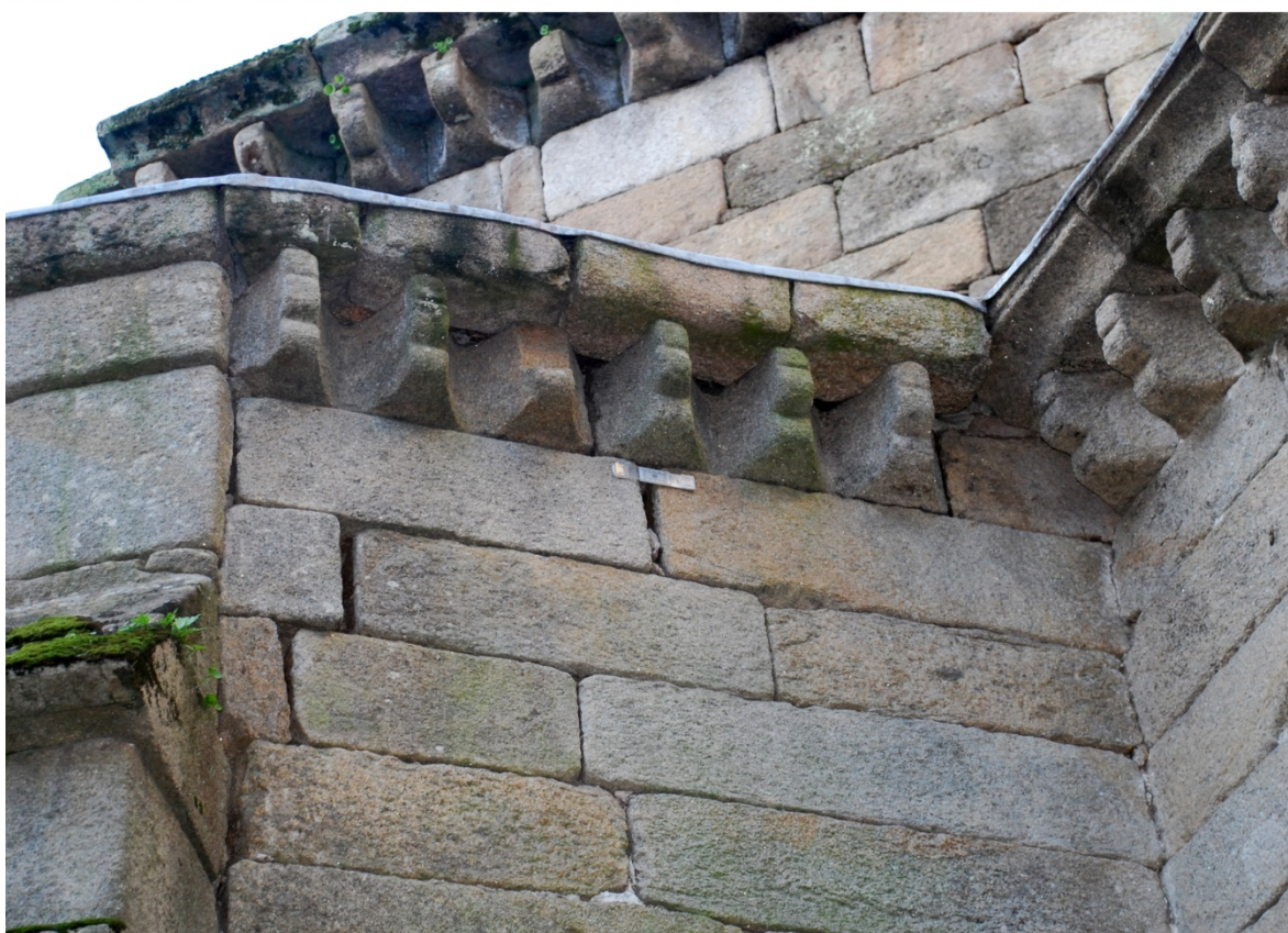
Figura 10: la alteración cromática es irreversible porque se debe a una alteración de algunos de los minerales que componen el granito. En los edificios históricos es frecuente encontrar este tipo de “discontinuidades” porque en muchos casos, el granito ya estaba alterado cuando se extrajo de la cantera. Dentro de las fábricas se producen alteraciones cromáticas diferenciales (o pátinas), porque unos sillares están afectados y otros no.
