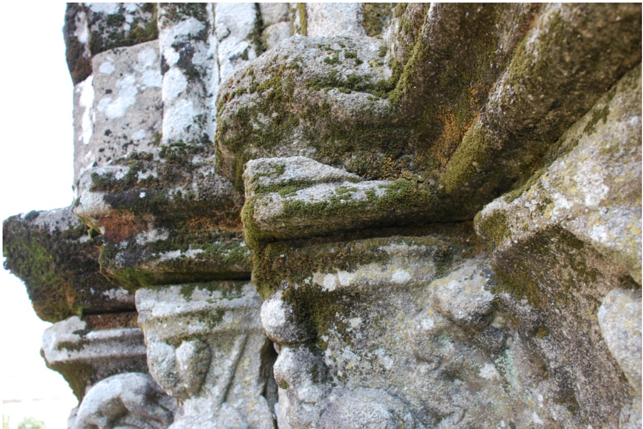
Figura 12: la colonización moderada, de líquenes endolíticos aporta calidez al edificio (pátina biológica), sin embargo, las colonizaciones que forman una costra densa, además de retener humedad ocultan las formas y posibles lesiones de la fábrica. Las labores de mantenimiento son imprescindibles para mantener controlada la densidad de la colonización.
