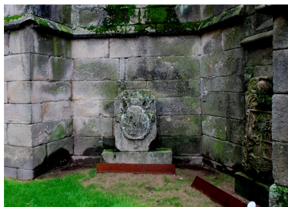
Figura 9: a pesar de la protección de las cubiertas y de la instalación de bajantes, está claro que se producen escorrentías y retenciones de humedad que favorecen la colonización. En los salientes de la fábrica no es posible o fácil controlar la retención de humedad, pero en las partes bajas de la edificación se puede mejorar mucho la situación. Además, en estas zonas se producen alteraciones importantes con pérdida de material.
