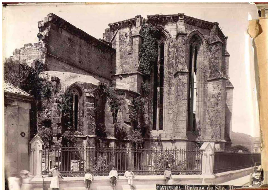
Figura 1: la fotografía superior es probablemente del momento de paralización de la demolición (Zagala, ca. 1895). En la segunda, recogida en el Inventario de Balsa de la Vega (1907 o 1908), ya se puede ver que el trasdós de las bóvedas está consolidado.
