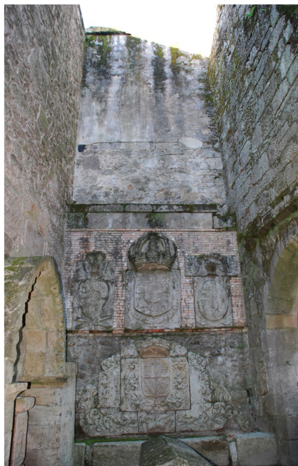
Figura 8: superior, vista de la solución adoptada para proteger las bóvedas. Evita la entrada de agua al interior y la colonización de plantas superiores que en otros tiempos se establecían en estas zonas.
