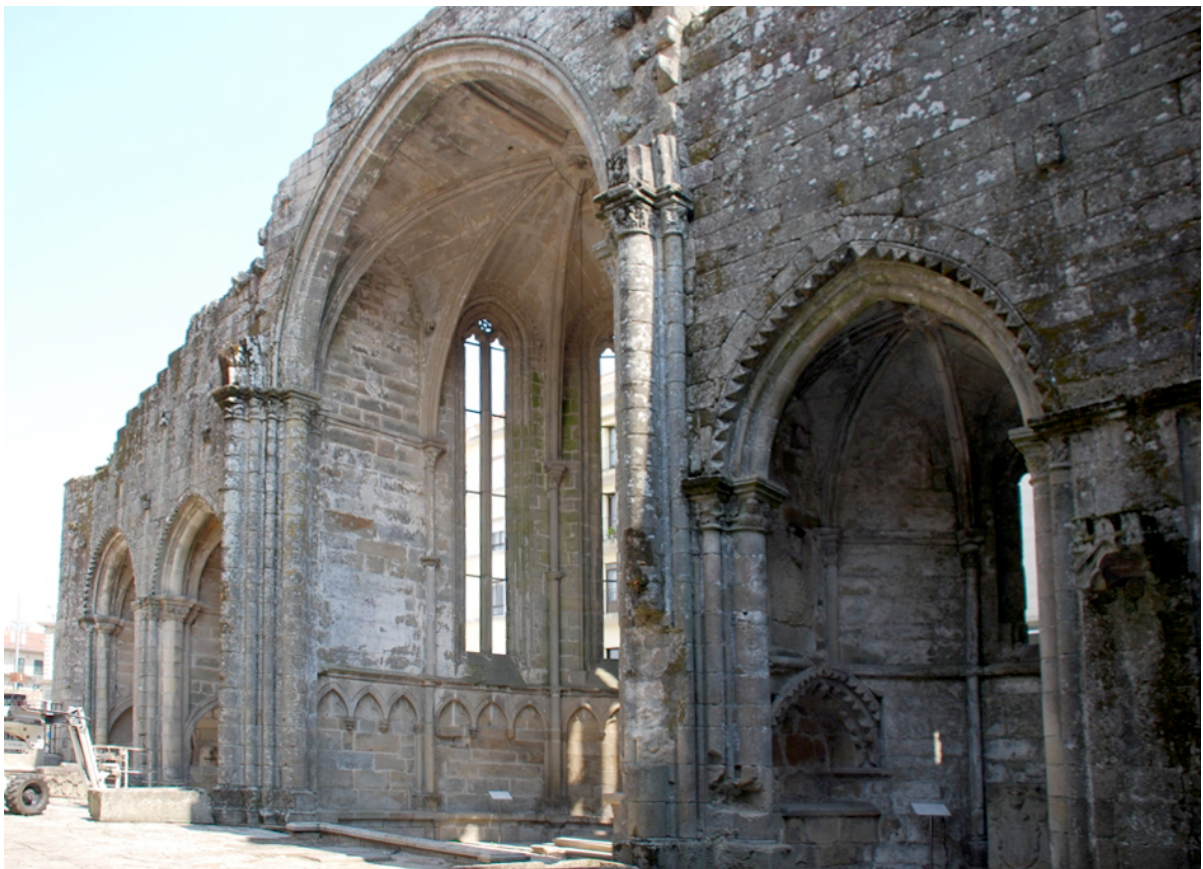
Figura 6: aspecto actual del interior de los ábsides. La imagen difiere poco de las de hace un siglo. La colonización es intensa en las caras expuestas, en las que tienen que ver las escorrentías difíciles de controlar.
