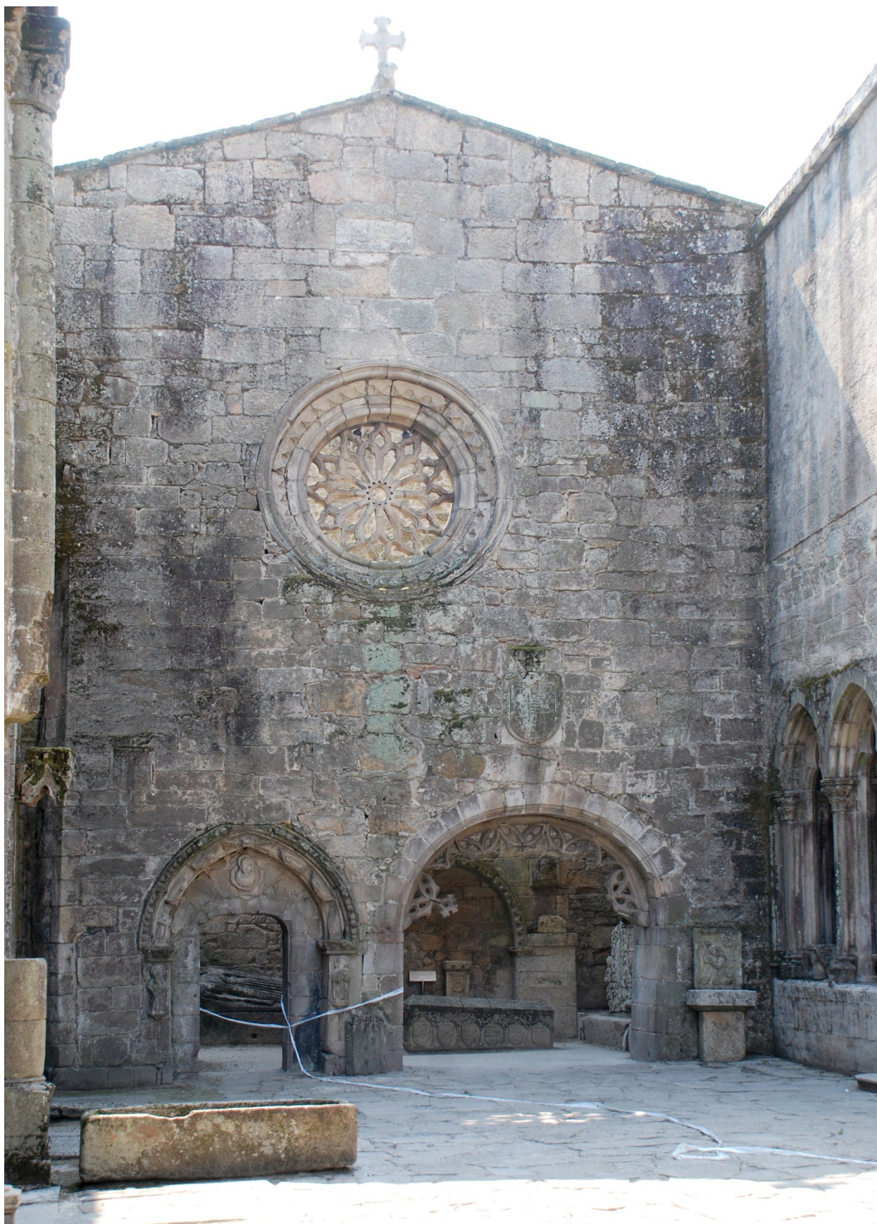
Figura 7: vista del hastial reconstruido y de una parte de la arquería del claustro, completamente descontextualizada.
