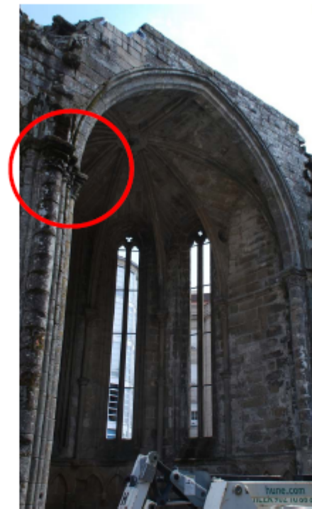
Figura 22. Vista general ábside 3.
