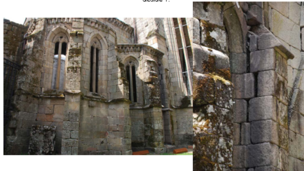
Figura 4.14. Vista general y de detalle de las aberturas en los paños exteriores de los muros.
