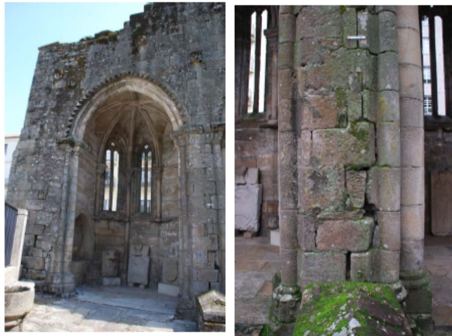
Figura 4.13. Imagen general y de detalle de las aberturas en los elementos de sustentación del ábside 1.
