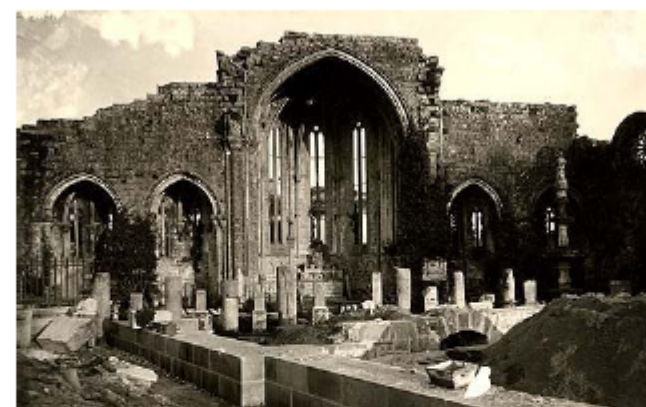
Figura 1. Estado de las ruinas en 1903 (tomada del web del Museo de Pontevedra)
