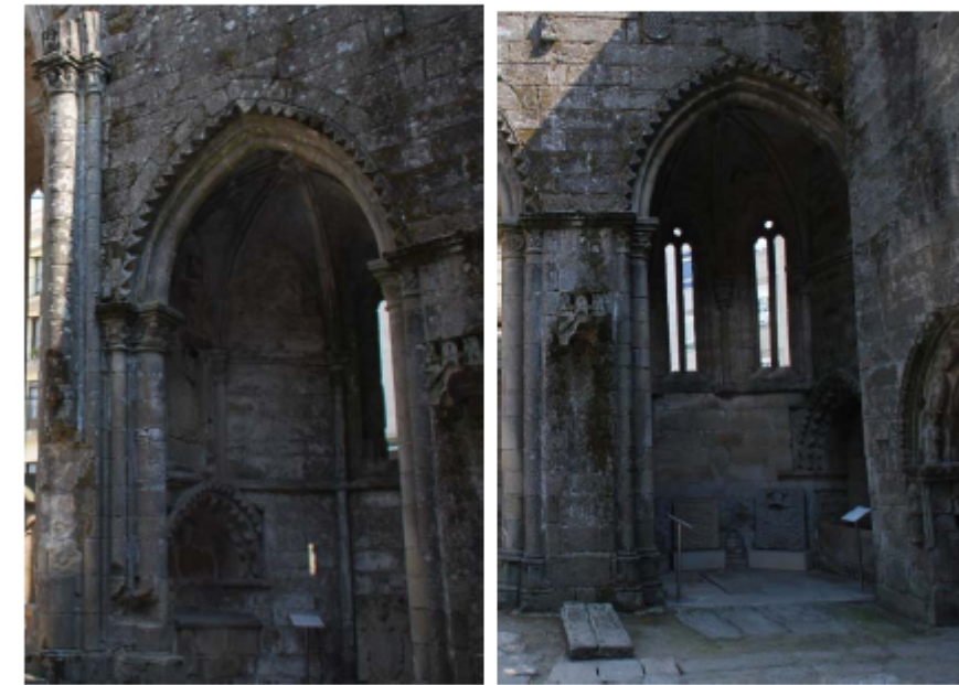
Figura 10. Vista general del ábside 4 y ábside 5
