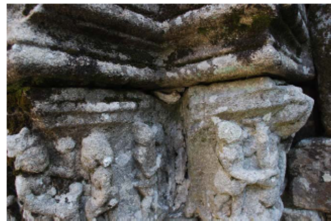
Figura 4.25. Aspecto degradado que presentan las tallas del capitel.
