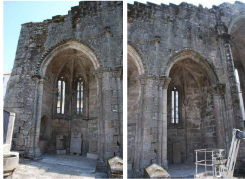
Figura 8. Vista general del ábside 1 y ábside 2.
