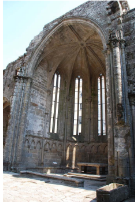
Figura 9. Vista general del ábside 3.
