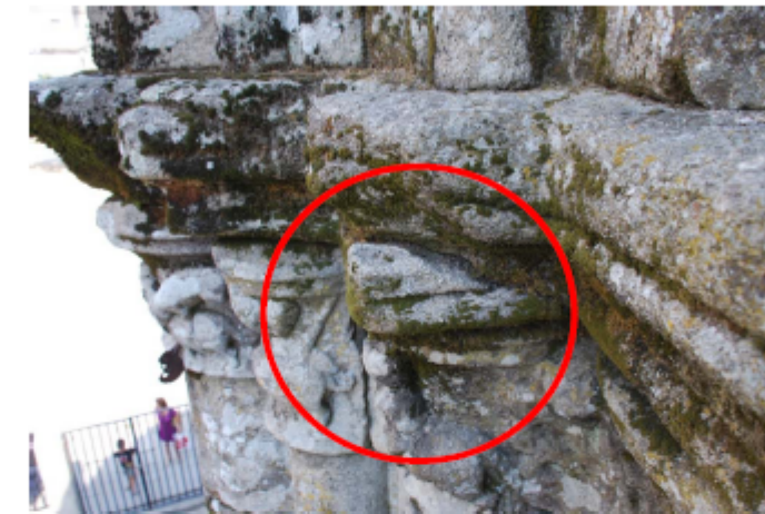
Figura 23. Vista frontal de Imposta sobre el capitel izquierdo del ábside 3.
