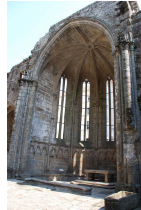
Figura 4.6. Vista general del ábside 3.
