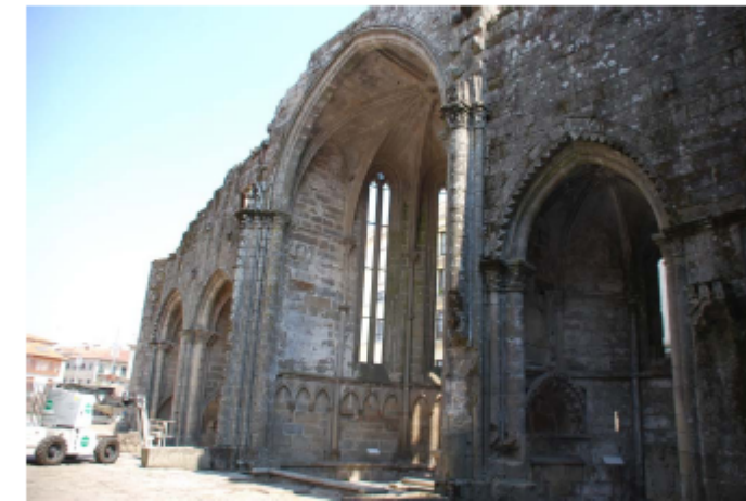
Figura 7. Vista interior de las ruinas de la Iglesia.
