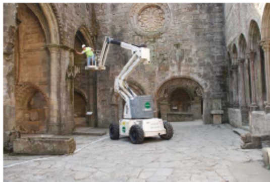
Figura 2. Inspección de detalle del estado del edificio.
