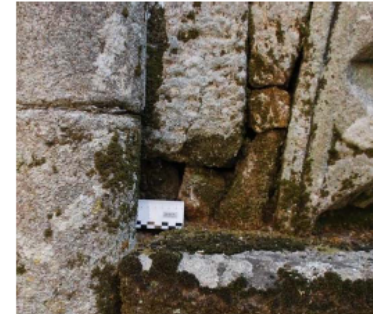
Figura 28. Vista frontal del hueco sobre el capitel derecho del ábside 3.
