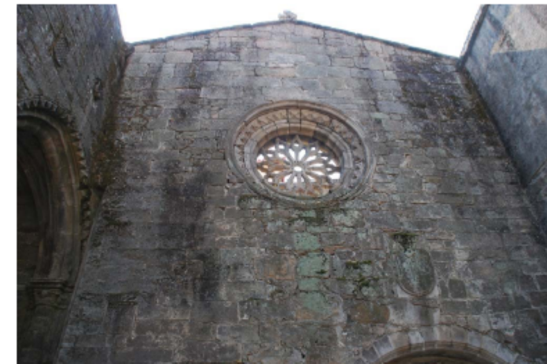
Figura 11. Muro frontal del ala derecha de la iglesia.
