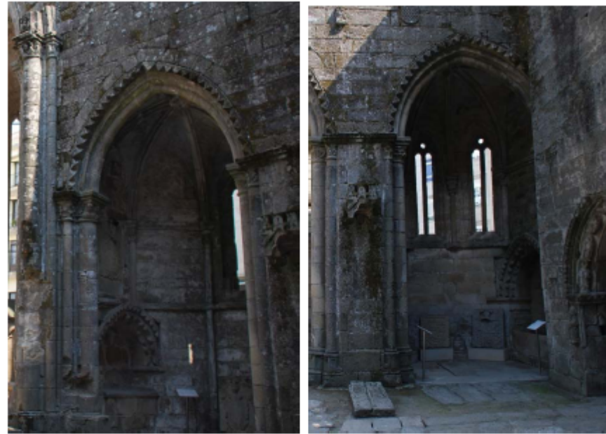
Figura 4.7. Vista general del ábside 4 y ábside 5
