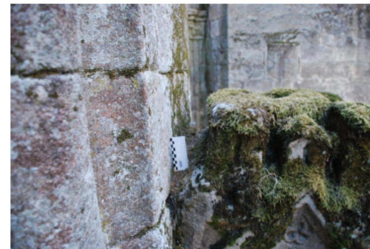
Figura 37 Colonización de musgo en pieza que sobresale de la fábrica.
