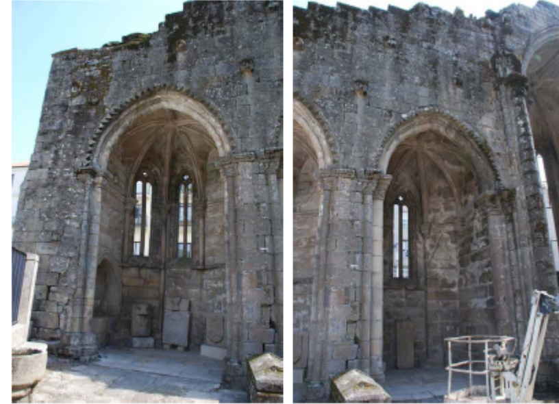
Figura 4.5. Vista general del ábside 1 y ábside 2.
