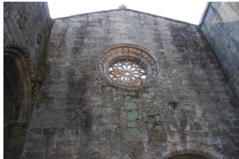
Figura 4.8. Muro frontal del ala derecha de la iglesia.
