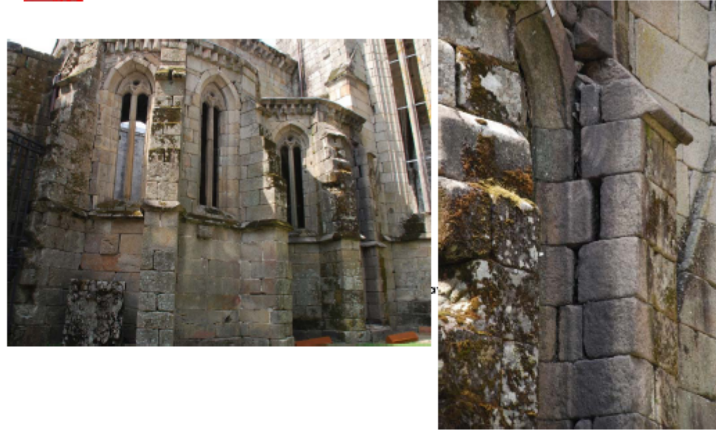
Figura 31. Vista general y de detalle de las aberturas en los paños exteriores de los muros.
