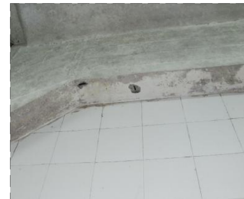
FOTO 31 UBICACIÓN: Vestuario 3. Portico II. PAATOLOGÍA: Oxidación de armaduras y desplazamientos de hormigón de protección exterior. CAUSAS POSIBLES: Entrada de agua hacia la armadura con la consiguiente oxidación, hinchamiento y desplazamiento del hormigón de protección de las armaduras. REPARACIONES: Descubrir las armaduras afectadas (barras longitudinales y transversales). Limpieza, saneamiento y pasivación de zonas afectadas según procedimientos de reparación marcados en plano ERO7.
