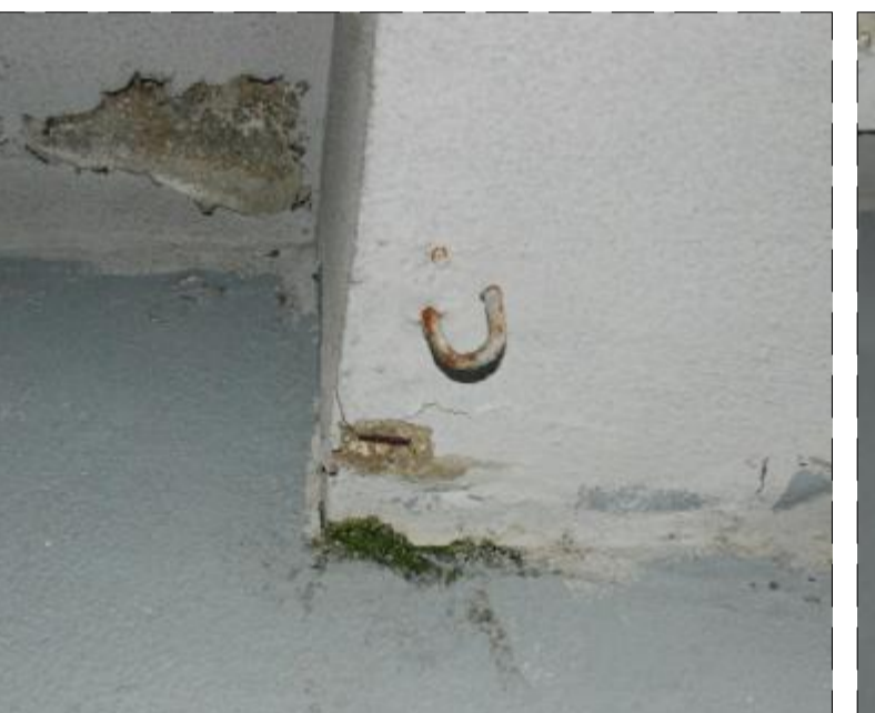
FOTO 36 UBICACIÓN: Acceso a Vestuario 3 y 4. Zanca nº 5. PAATOLOGÍA: Oxidación de armaduras y desplazamientos de hormigón de protección exterior. CAUSAS POSIBLES: Entrada de agua hacia la armadura con la consiguiente oxidación, hinchamiento y desplazamiento del hormigón de protección de las armaduras. REPARACIONES: Descubrir las armaduras afectadas (barras longitudinales y transversales). Limpieza, saneamiento y pasivación de zonas afectadas según procedimientos de reparación marcados en plano ERO7.
