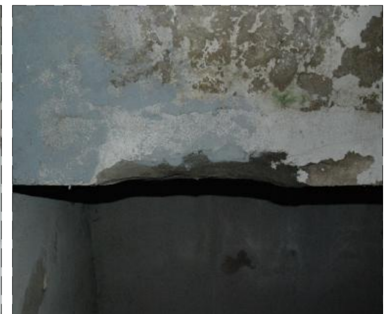
FOTO 32 UBICACIÓN: Acceso a Vestuario 3 y 4. PAATOLOGÍA: Recorte de recubrimientos interiores en viga de H.A. CAUSAS POSIBLES: Falta de apoyo de acceso desde niveles inferiores. REPARACIONES: Descubrir las armaduras afectadas (barras longitudinales y transversales). Limpieza, saneamiento y pasivación de zonas afectadas según procedimientos de reparación marcados en plano ERO7.
