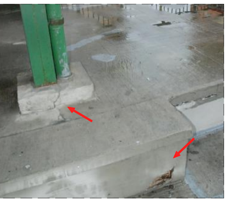
UBICACIÓN: Vestuario 6. Tabique de cierre con gradas. PATOLOGIA: Grietas que recorren el tabique desde el dintel de la ventana hasta las esquinas. La grieta discurre entre las juntas del alicato. CAUSAS POSIBLES: Deformación excesiva de la estructura. La grieta parece que no está activa. REPARACIONES: Levantamiento del alicato y mortero. Colado del tabique en la zona dañada y reposición de mortero. Colocación del nuevo acabado superficial.
