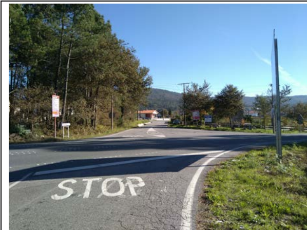
Vista de la intersección de la EP-8703 con la EP-8001
