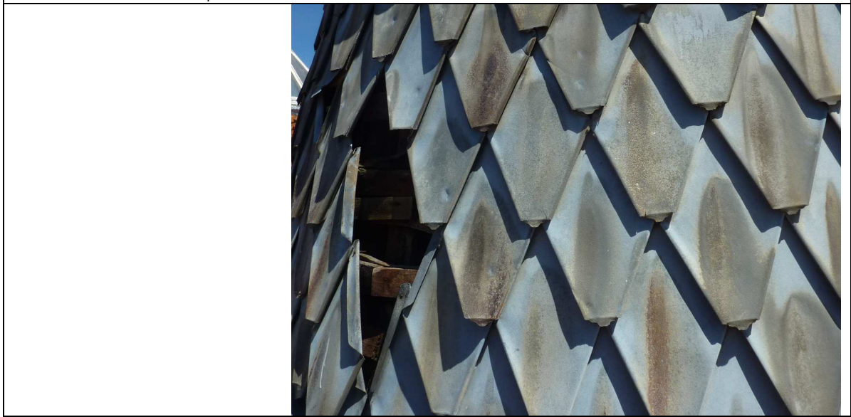
Detalle escamas de zinc en lucernario
