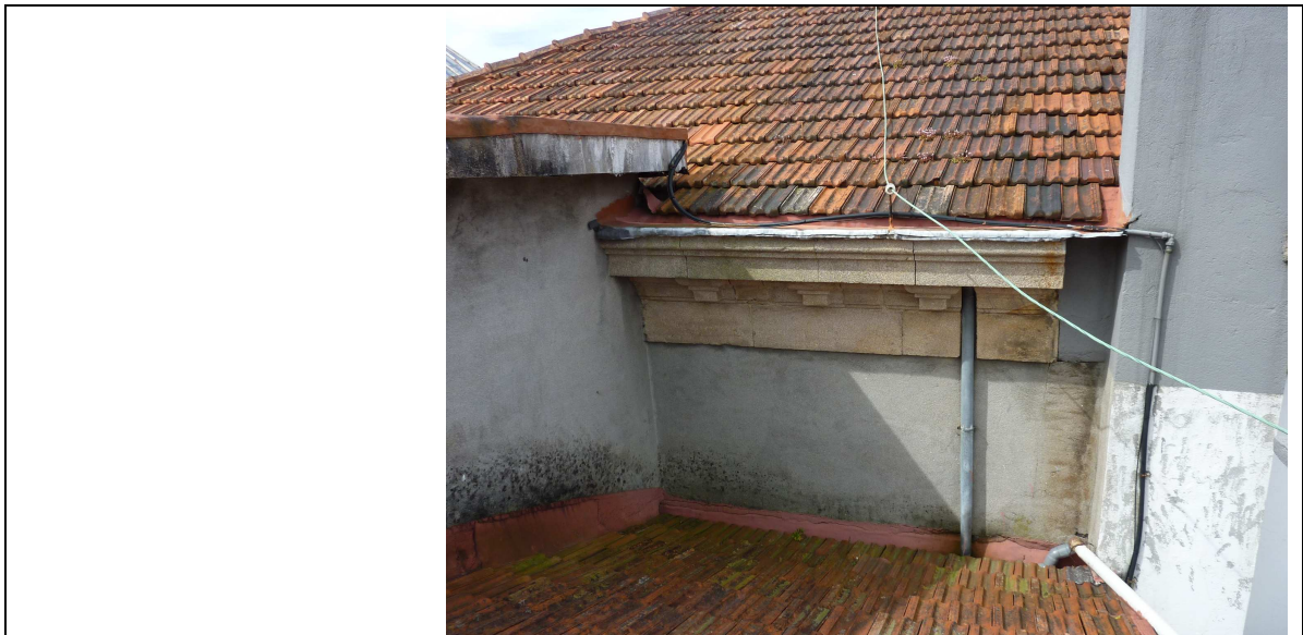
Encuentro entre faldones a patio interior
