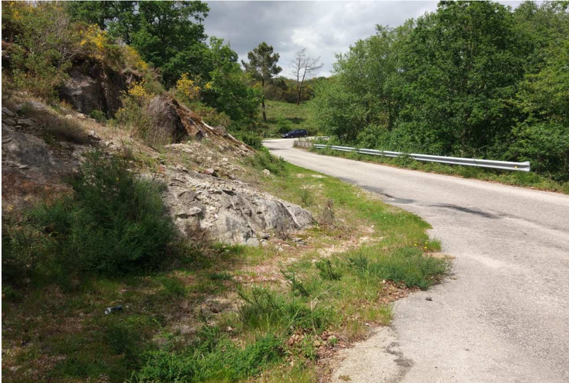
Foto 3. P.K.0+290. Zona de saneo e ensanche no acceso a ponte.
