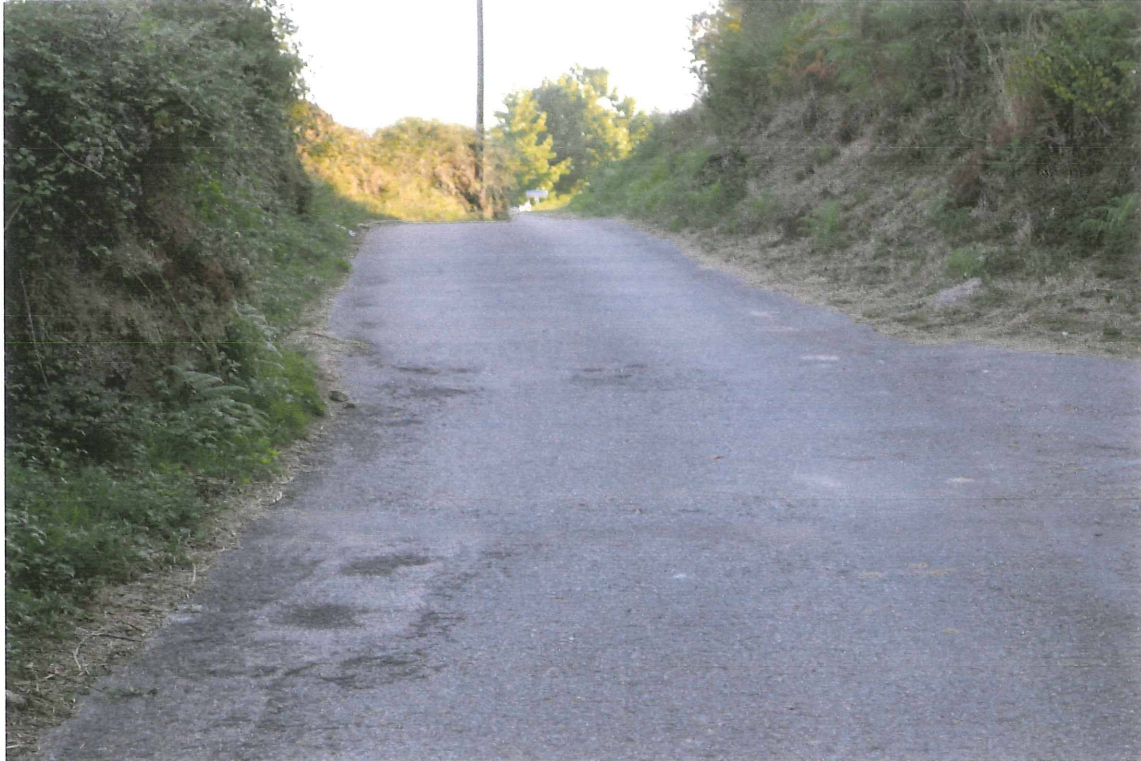
REBOREDO – CAMINO. Tramo inicial del camino a reparar.
