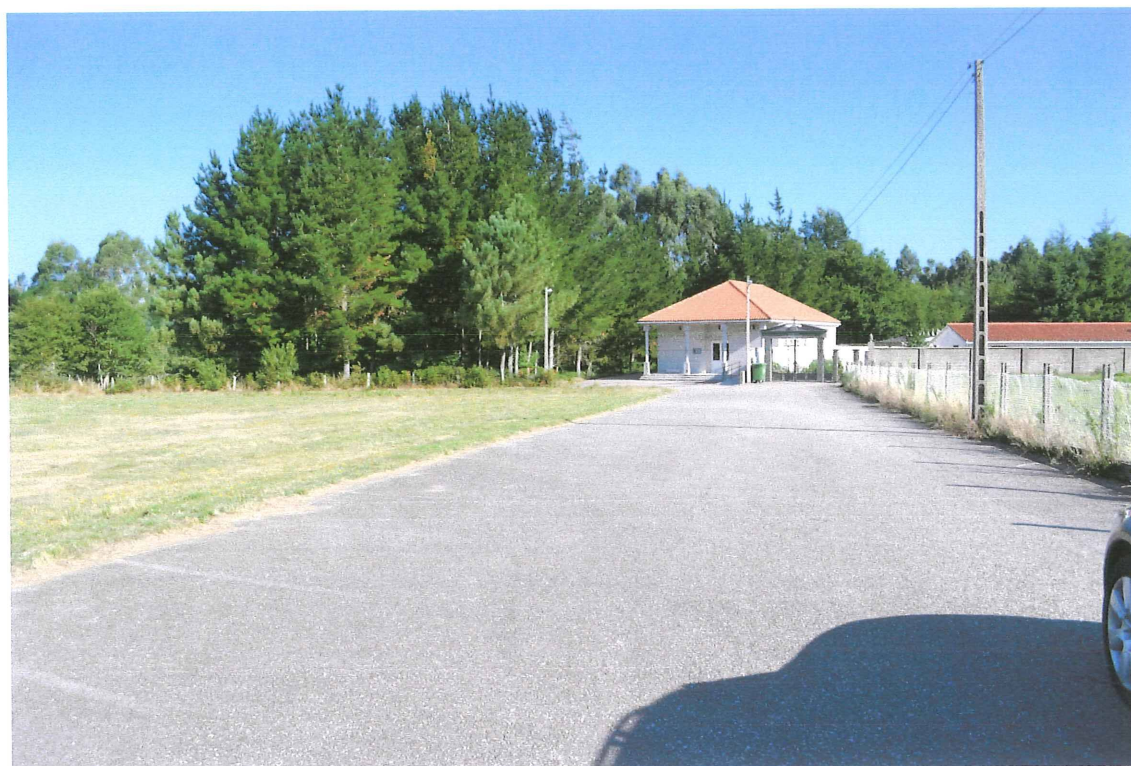
COUSO. Zona norte del aparcamiento.
