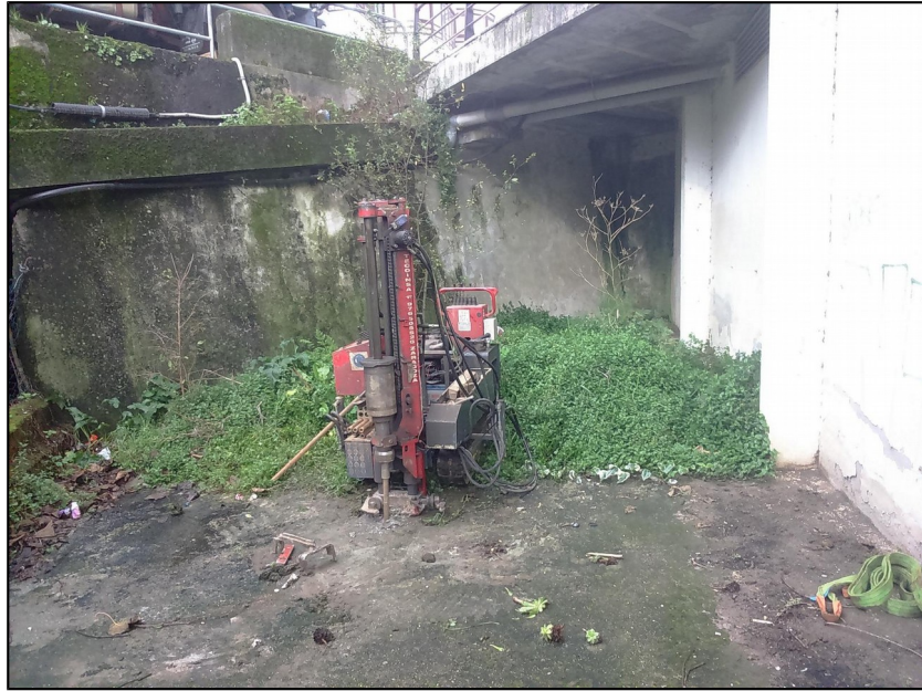
Vista del equipo de penetración dinámica en el punto P-2.
