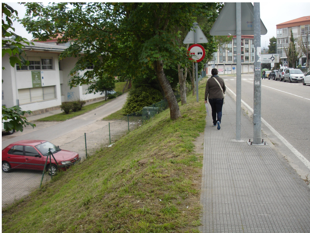
FOTO Nº 6 Beirarrúa en vial a demoler.
