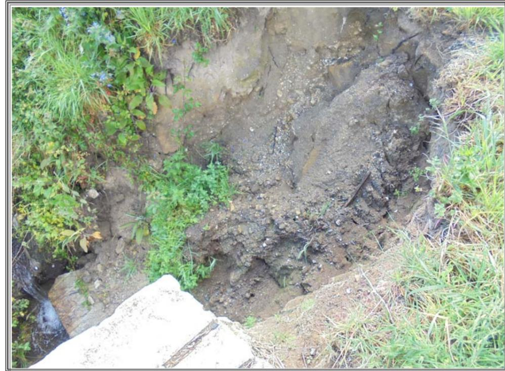
Foto 12: Vista detalle del material deslizado en el lateral del muro de mampostería
