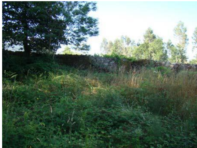
Zona do peche afectada. Cara Leste
