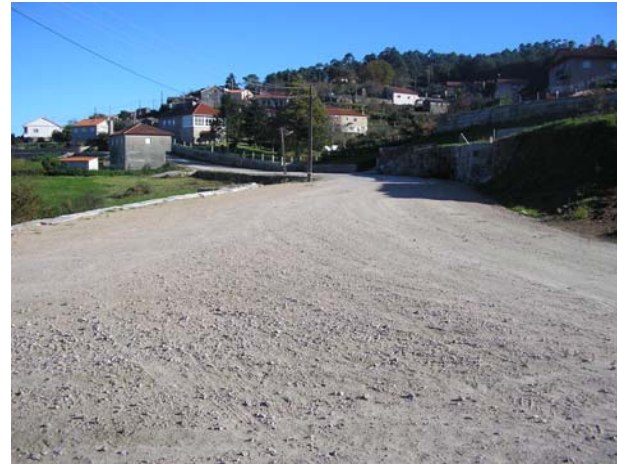
CARRETERA EP 9406 P.K. 15+080
