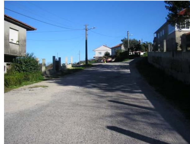
CARRETERA EP 9406 P.K. 15+200
