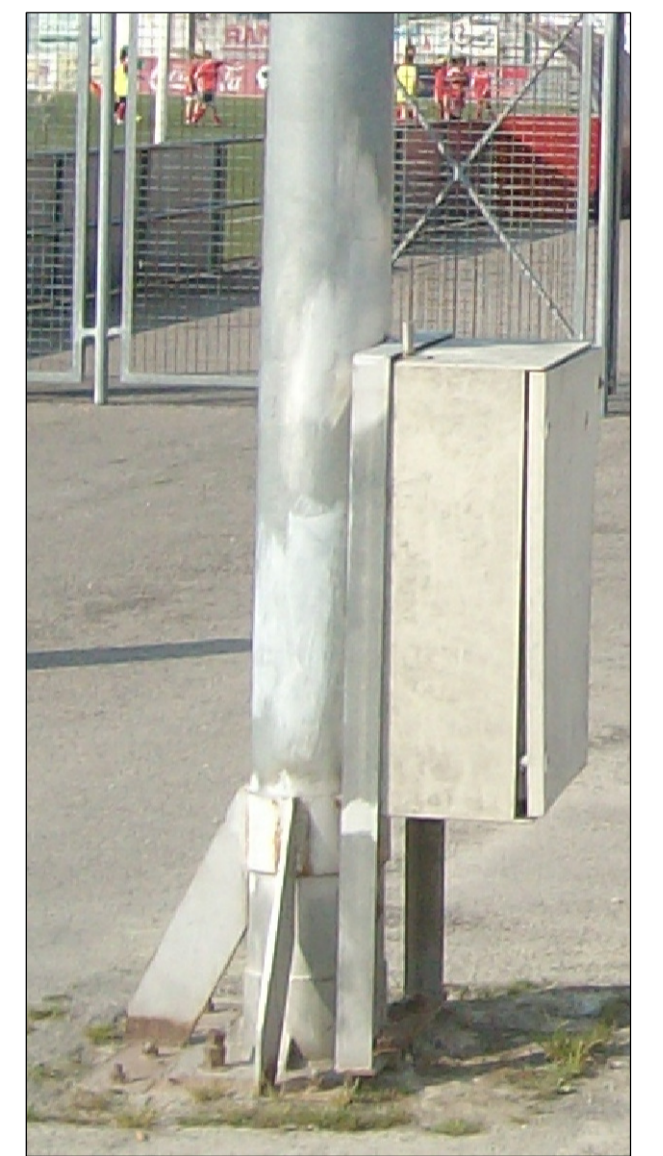
DETALLE ANCLAJE Y CUADRO ELECTRICO EXISTENTE
